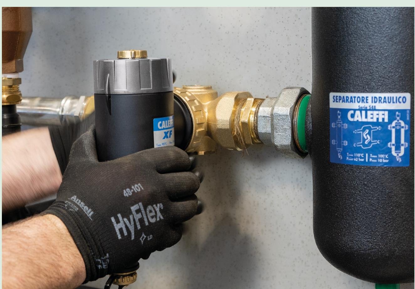
Um zur Energiewende beizutragen, sind u.a. effiziente und ordnungsgemäß betriebene Wärmesysteme notwendig. Der CALEFFI XF Serie 577, ein halbautomatischer, selbstreinigender Schlammabscheider mit Magnet, garantiert eine hervorragende Systemreinigung, gewährleistet hohe Leistung und maximale Effizienz.
